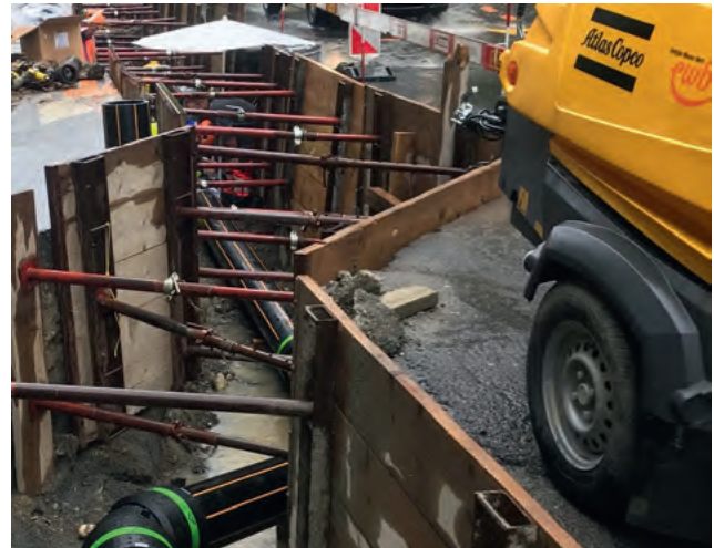
Abb. 6: Baustellenbedingungen: Installationen von Heizwendel-Formstücken unter dem Schirm bei Regen
