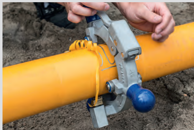
Abb. 11: Rohr-Oberflächenbearbeitung mit einem Kombigerät, welches Rohrenden- und -sattelflächenbearbeitung erlaubt.
