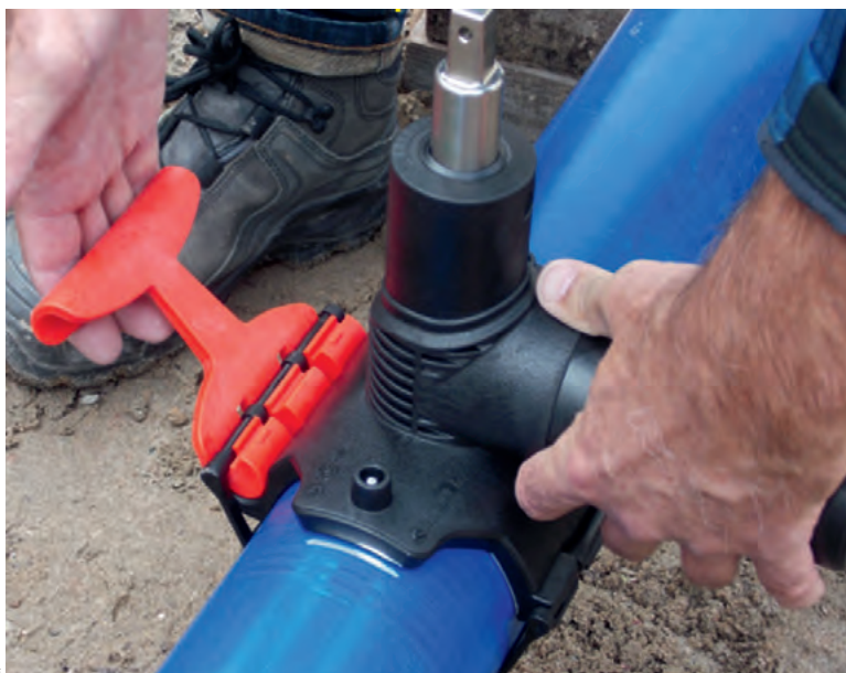
Abb. 9: Werkzeugfrei sicher montiert: Druckanbohrventil mit integriertem Schnellspannhebel
