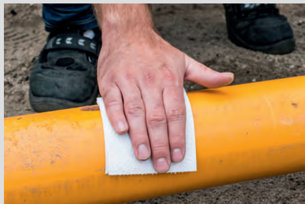
Abb. 10: Säubern der Rohre
