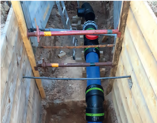
Abb. 5: Winkelformstücke erlauben größtmögliche Flexibilität bei komplexer Leitungsführung und helfen, verspannte Einbausituationen zu vermeiden.
