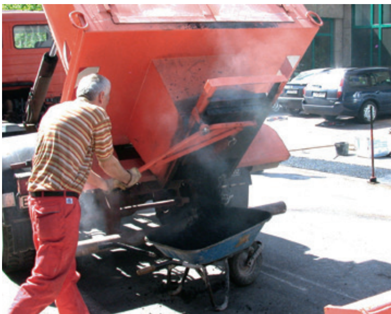
Abb. 3: Thermobehälter zum Transport von Asphaltmischgut
