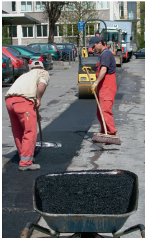
Abb. 2: Wiederherstellung der Asphaltoberfläche im Handeinbau
