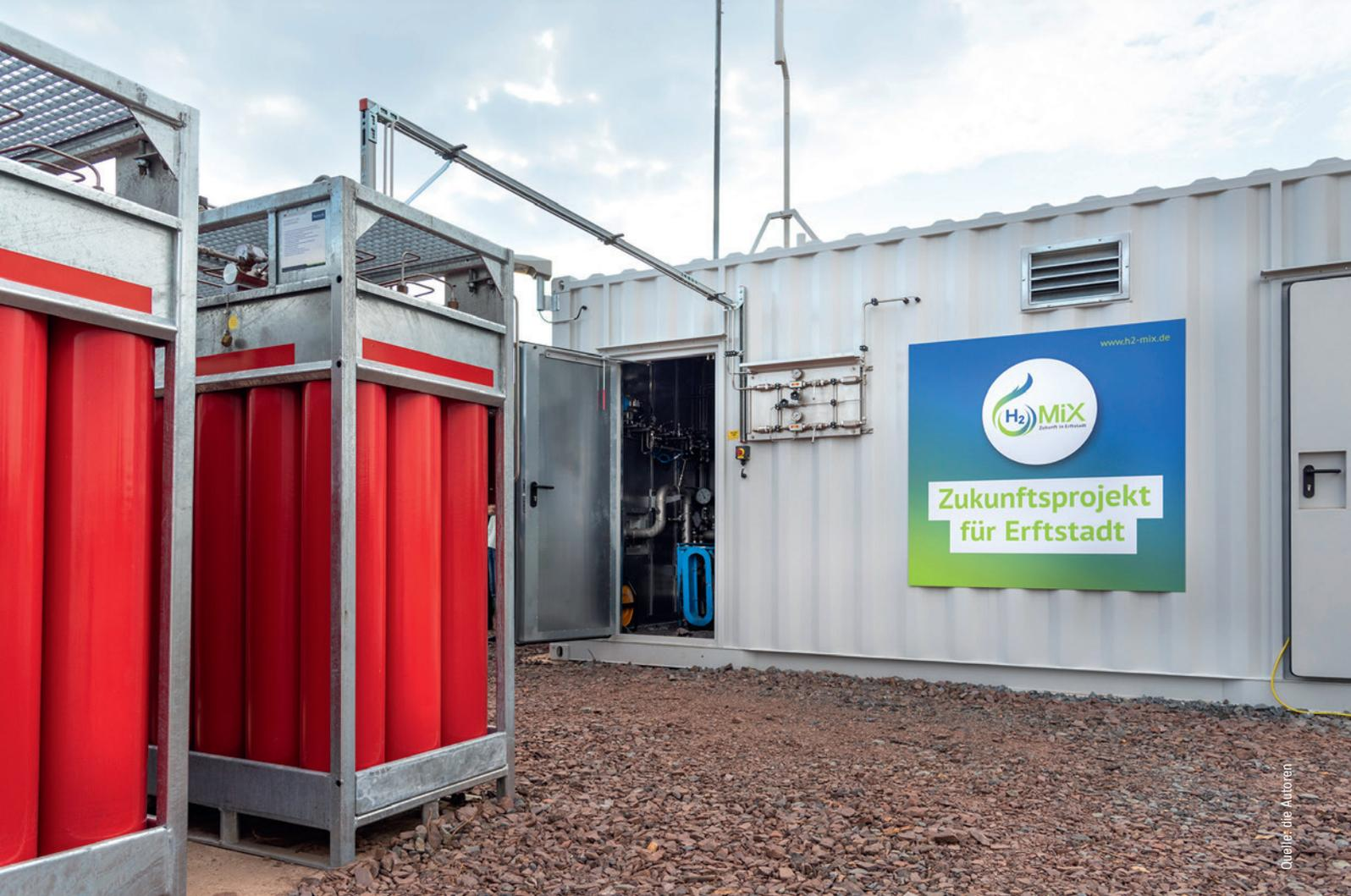
Abb. 1: Einspeiseanlage mit H<sub>2</sub>-Speicherbatterie
