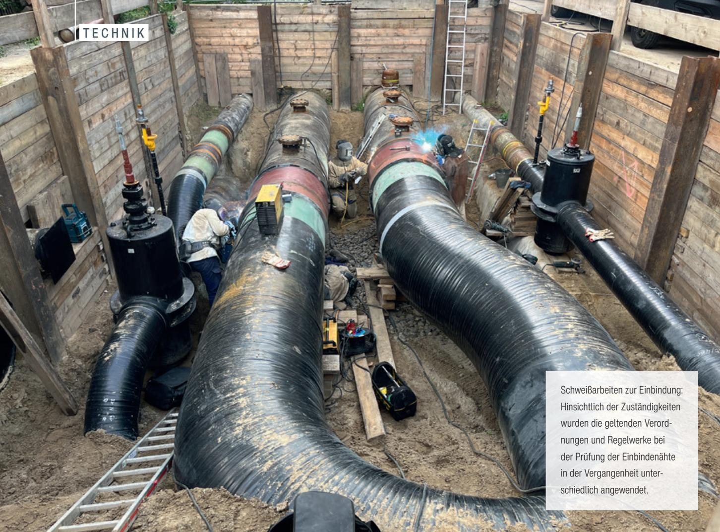
Schweißerarbeiten zur Einbindung: Hinsichtlich der Zuständigkeiten wurden die geltenden Verordnungen und Regelwerke bei der Prüfung der Einbindenähte in der Vergangenheit unterschiedlich angewendet.
