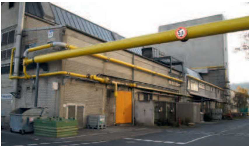
Abb. 3: Freiverlegte Gasleitung
