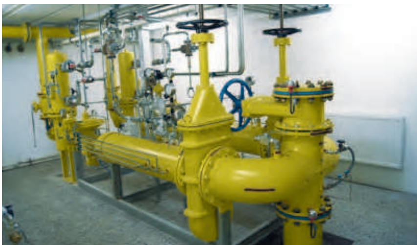
Abb. 2: Gas-Druckregelanlage
