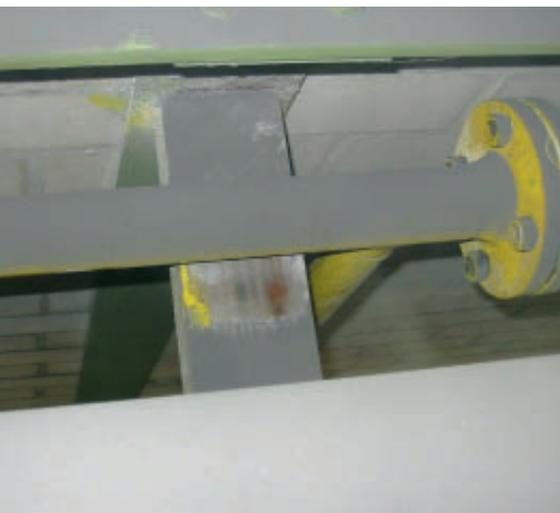
Starke Schwingungen an einer Stahlleitung DN 80
