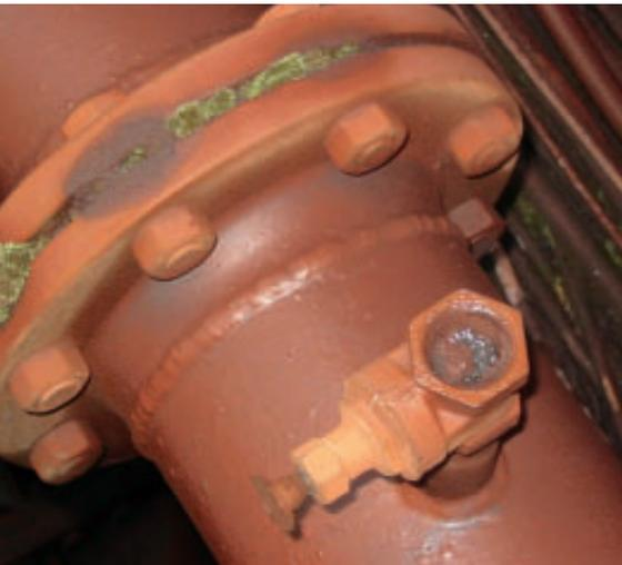
Mehrere Fehler auf einmal: Undichtheit (hier mit Schaum bildendem Mittel kenntlich gemacht), fehlende Verwahrung, nicht für die Gasversorgung zugelassene Armatur, falsche Kennzeichnung und Moosbewuchs am Flansch
