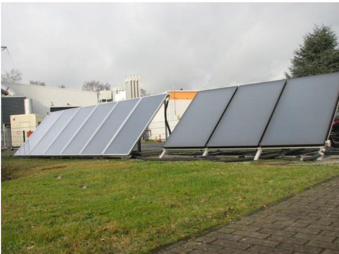
**Abbildung 128:** Solarthermiemodule für die Brennwert plus Solar- und Gaswärmepumpenanlage
