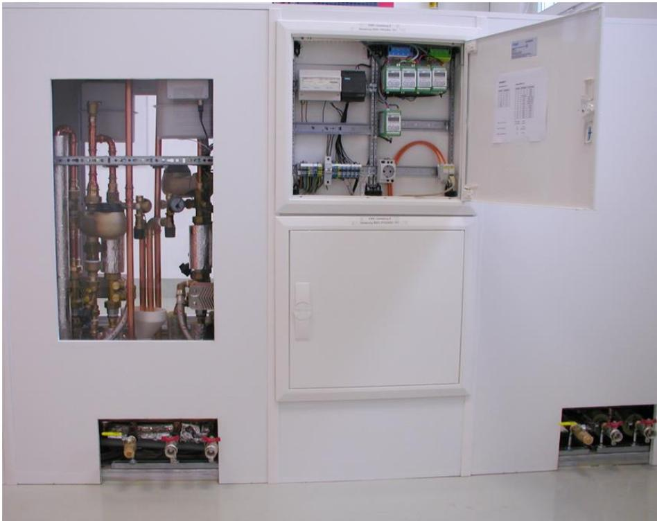
Abbildung 135: Installationswand mit Sichtöffnung und Schaltkasten
