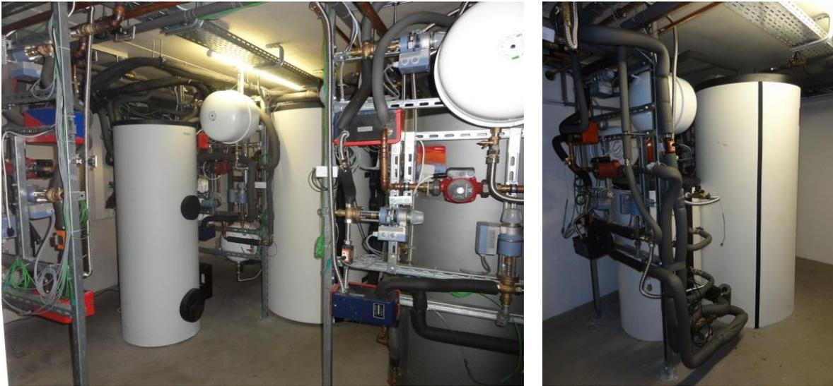
**Abbildung 131:** Installationsstationen und Speicher in den Kellerräumen
