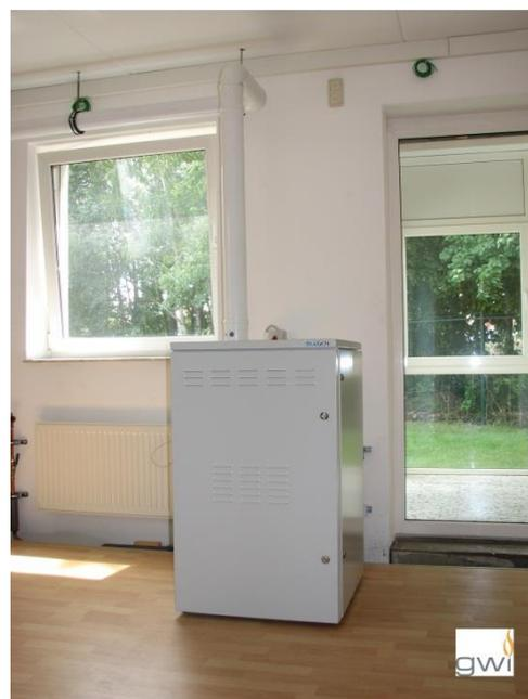
Abbildung 69: Brennstoffzelleninstallation im GWI-Versuchshaus
