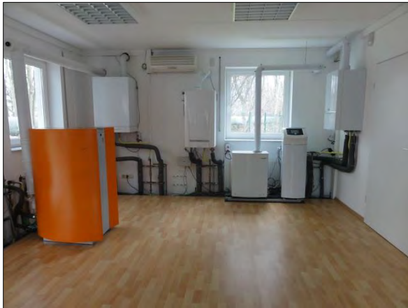
Abbildung 2.2: Im Demonstrationshaus installierte KWK-Geräte (links), Wärmepumpen, Brennwertkessel und Brennstoffzelle (rechts)
