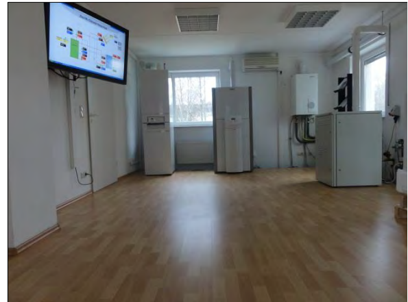
Abbildung 2.2: Im Demonstrationshaus installierte KWK-Geräte (links), Wärmepumpen, Brennwertkessel und Brennstoffzelle (rechts)
