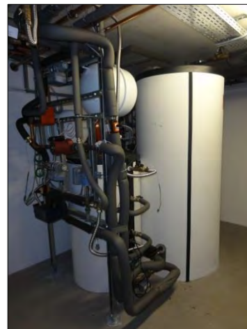
Abbildung 2.2: Im Demonstrationshaus installierte KWK-Geräte (links), Wärmepumpen, Brennwertkessel und Brennstoffzelle (rechts)
