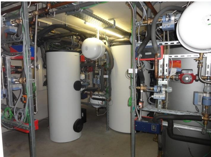
Abbildung 6-8: Installationsstationen und Speicher in den Kellerräumen
