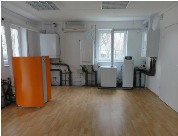
Abbildung 6-7: KWK-Geräte (links), Wärmepumpen, Brennwertkessel und Brennstoffzelle (rechts)
