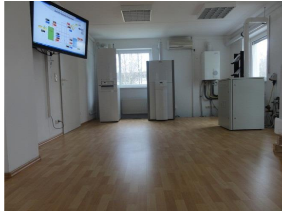
Abbildung 6-7: KWK-Geräte (links), Wärmepumpen, Brennwertkessel und Brennstoffzelle (rechts)
