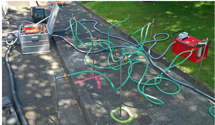
Abb. 2: Messung mittels Absaugmethode an einer erdverlegten Rohrleitung
