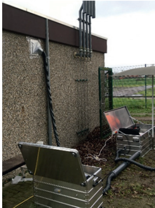
Abb. 3 (links): Messung mittels Absaugmethode an einer GDRMA
