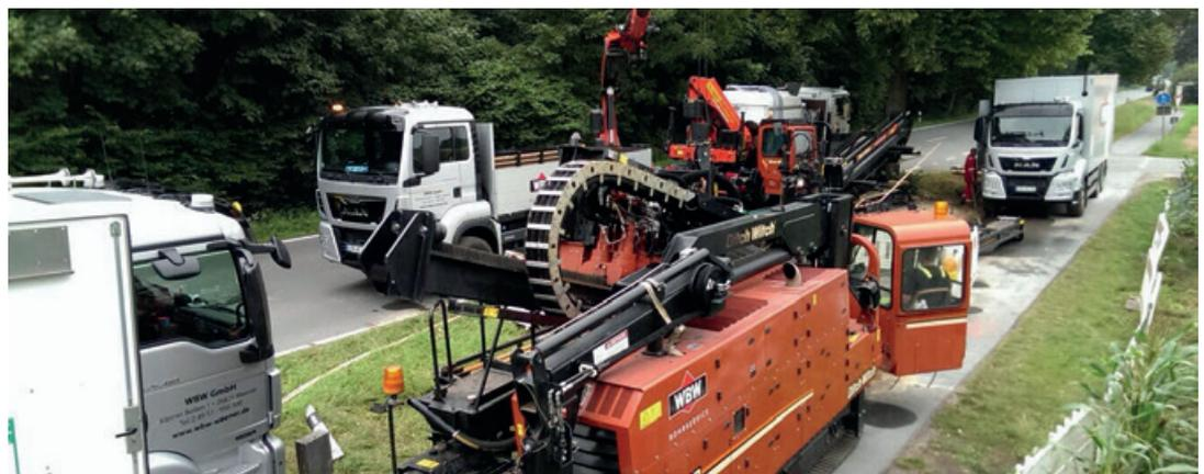
Grabenlose Rohrverlegung – Zertifiziert nach DVGW GW 302 GN2.
